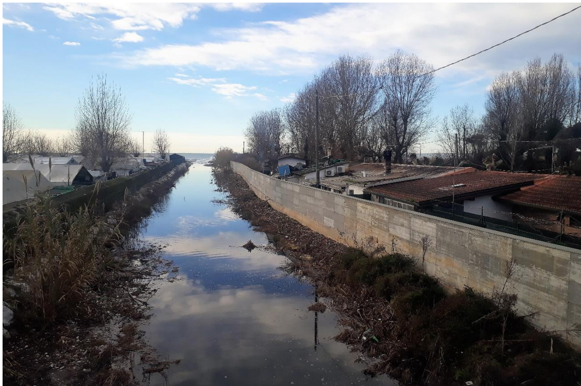
Figura 2.1 Nuova arginatura in sponda destra del tratto terminale del t.Parmignola, vista dal ponte litoraneo.
